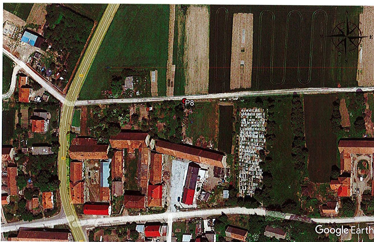
Lokalizacja punktu pomiarowego P8. Lusina 80 źródło: google maps
